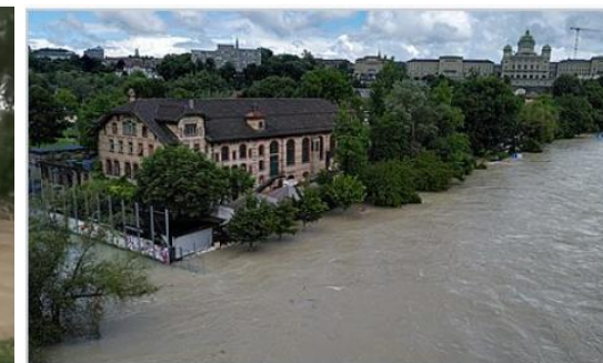
Hochwasser in Bern, 16. Juli 2021
